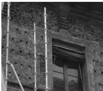
Figura 3 - Rondonara sulla parete di un palazzo, Bologna
