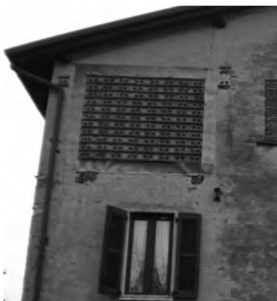
Figura 4 - Passerera sulla parete di una abitazione, Mornico a/S (BS)
